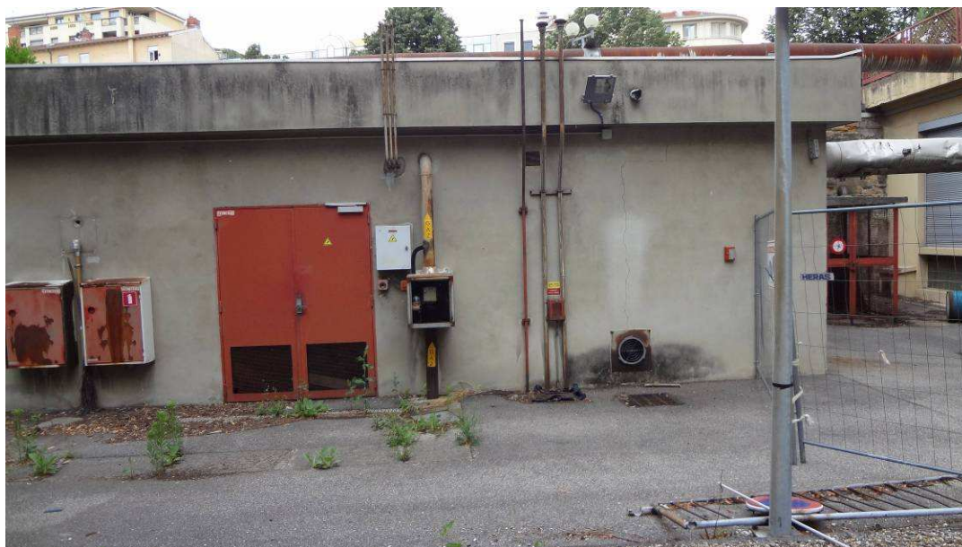
Façade de la chaufferie et événements des cuves. La pollution par hydrocarbures a été détectée au centre de la partie au premier plan.
