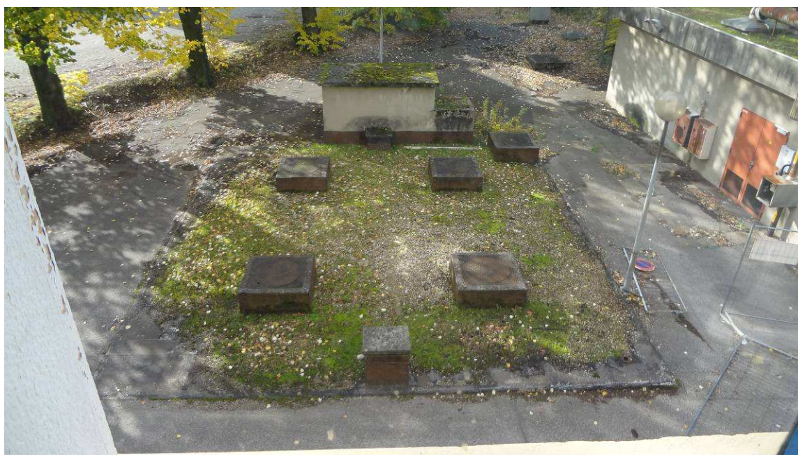
Cuves de fuel en fosse avec poste de livraison de fuel. Les 2 cuves sont placées dans la fosse bétonnée mais il n'y a pas de sable autour des cuves. En fond de plan, à droite, trou d'homme de la cuve supplémentaire alimentant sans doute le groupe électrogène.
